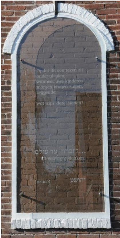
Rechterraam van het monument dat in 1993 is aangebracht aan de oostgevel van de voormalige synagoge in Winsum
